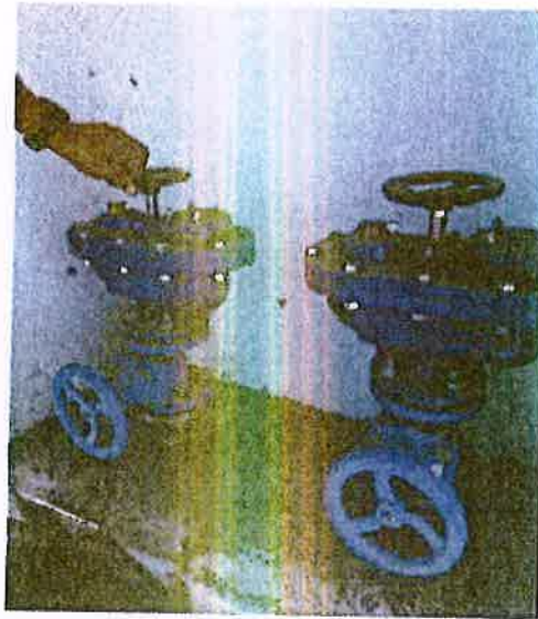
Figura 8 - Ventosas, em caixa, junto à rotunda do Texugo
