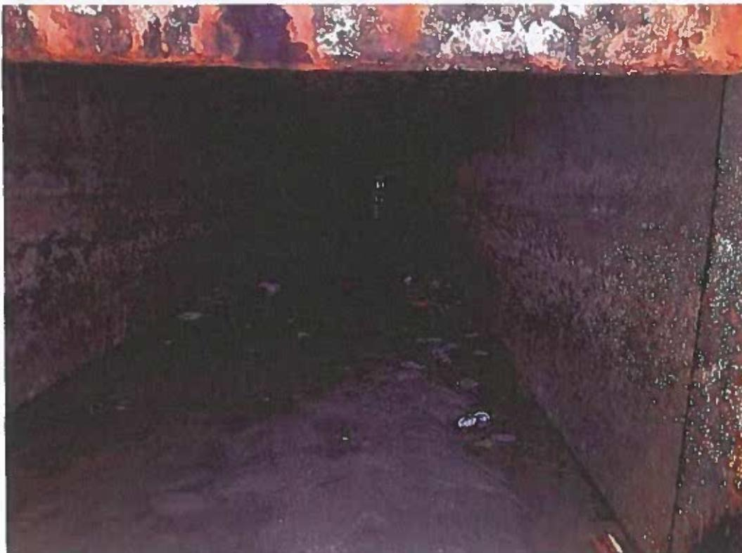
1. Ao longo do seu desenvolvimento existem tampas de acesso, cuja composição em termos de tipo de betão e quantidade de armadura desconhecemos. Estas tampas encontram-se furadas com tubagem de descarga de efluentes, provavelmente de esgoto doméstico. Para além da resistência desconhecida das tampas, os furos de passagem das tubagens enfraquecem a sua resistência.
