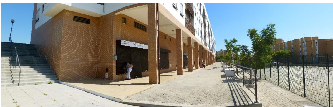
Figura 8. Fachada Exterior da Cozinha Partilhada de Alfazina
