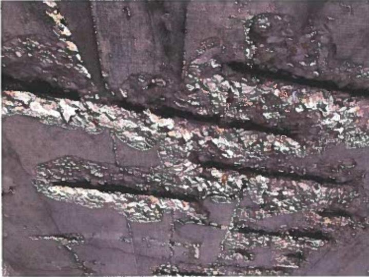
**Acesso 1 - As tampas em betão com espessura idêntica à da laje de cobertura e que permitiam o acesso ao interior do “túnel” foram alegadamente retiradas e substituídas por uma laje aligeirada**
