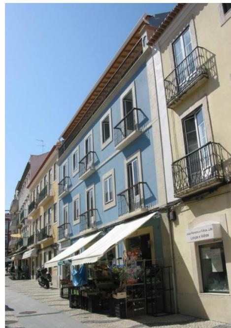
Rua Cândido dos Reis 102 a 106 - Edifício particular que foi alvo de construção de uma segunda fachada sobre a original, que se supõe nos anos 50, e que se encontrava em risco de colapso. A fachada primitiva mantinha-se sob a que tinha sido montada e foi, entretanto, revelada.
