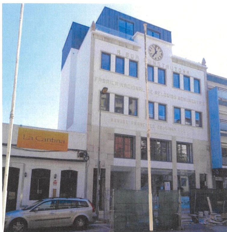
Rua Capitão Leitão 75
