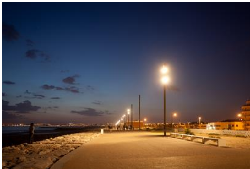
Troço de iluminação pública na Costa da Caparica controlada por telegestão
