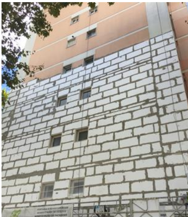
Aplicação de isolamento térmico em parede exterior de edifício habitacional existente
