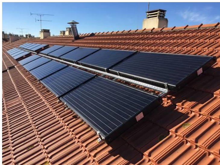
Sistema solar híbrido (térmico e fotovoltaico) instalado em edifício municipal com apoio do Fundo Climático
