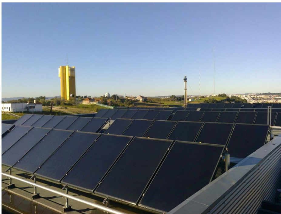
Campo de colectores solares da Piscina Municipal da Caparica
