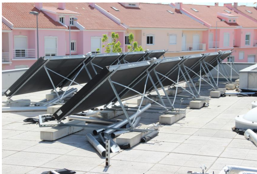
Campo de colectores solares da Piscina Municipal da Charneca da Caparica (com o circuito primário inutilizado)
